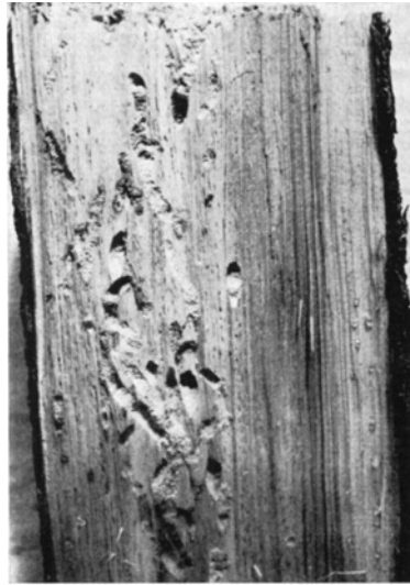
Abb. 6. Holzwespenfraß, bis in die Mitte des Stammes eindringend
